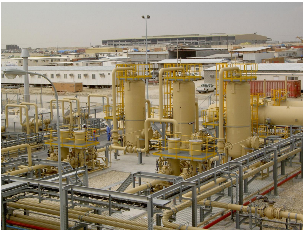
图 燃气处理系统约旦·萨姆拉电站二期
