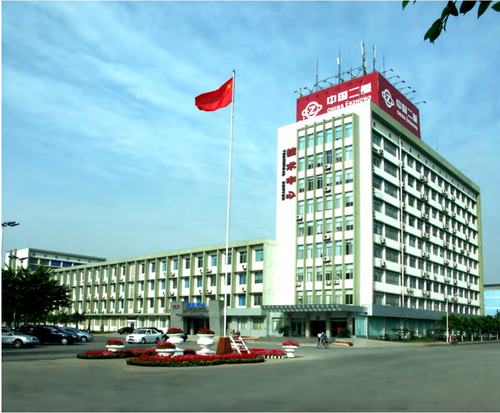
图二、集团公司技术中心大楼
